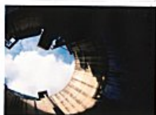
地下への入口。50m地下に雨水管が張り巡らされています。
